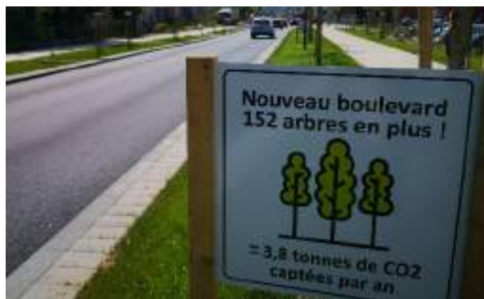
La nouvelle entrée de ville encourage les modes de circulation douce.
