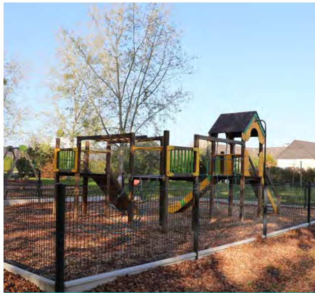
2020 : installation de nouvelles barrières au Parc d'Andaine
