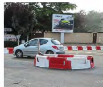
Les giratoires provisoires ont été installés aux deux carrefours où ils deviendront définitifs. | CREDIT PHOTO : OUEST-FRANCE
