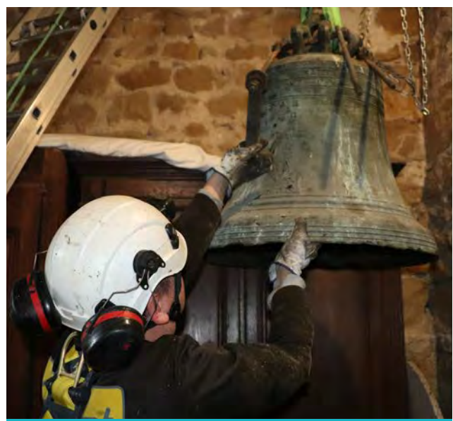
Dépose de « Gertrude », la cloche, avant sa rénovation
